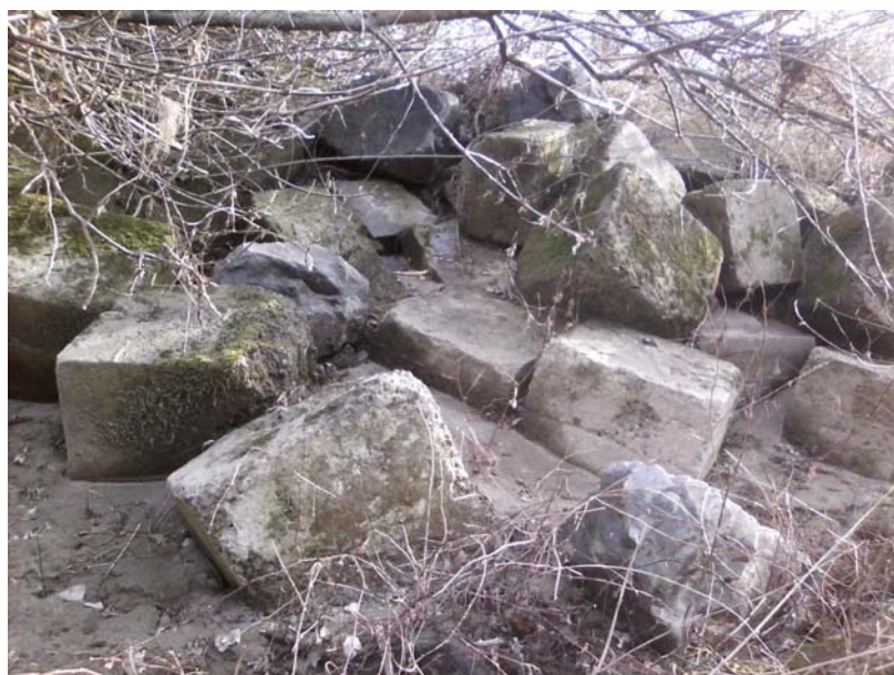
001-CAVADS005 – Difesa in prismi in cls sponda sinistra Fiume Bormida Loc. cimitero
