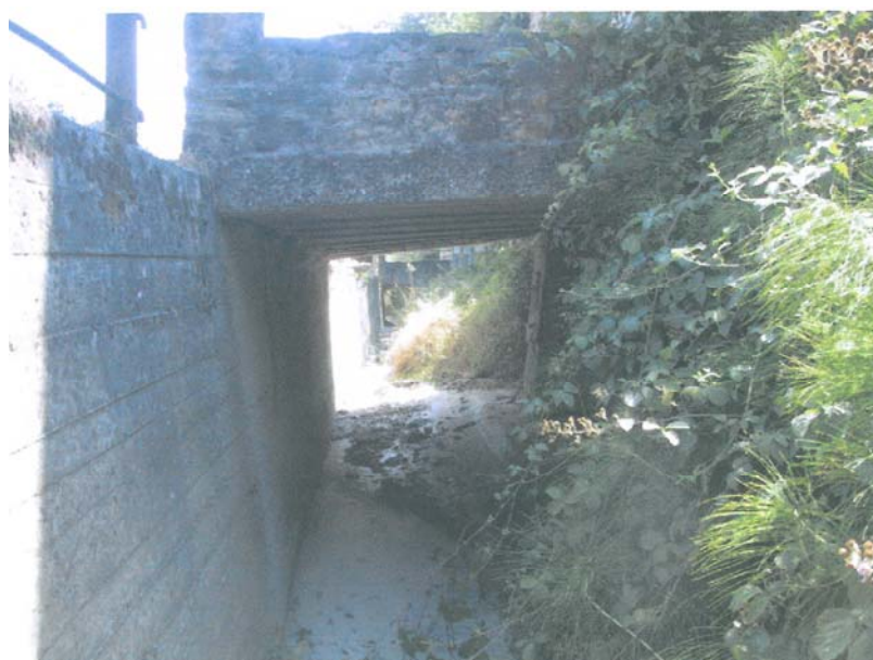
001-CAVAAG030 – Attraversamento Rio della Valle Loc. Ciravegna
