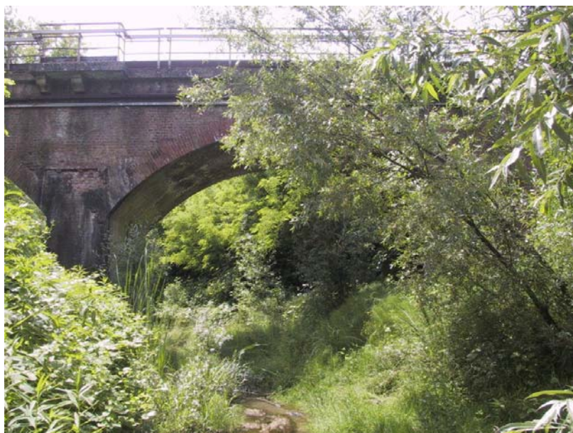
001-CAVAPO009 – Ponte ferroviario in muratura visto da monte
