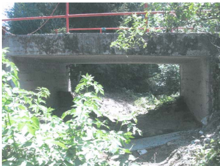
001-CAVAAG017 – Attraversamento Rio Casale Regione Bossalesio
