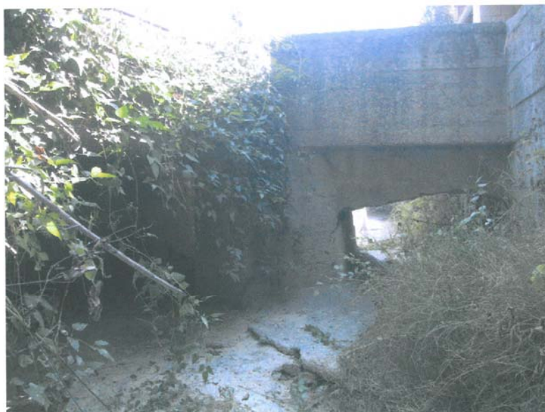
001-CAVAAG031 – Attraversamento Rio della Valle Loc. Ciravegna
