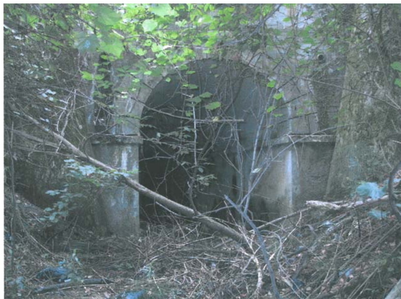
001-CAVAAG024 – Attraversamento Rio Gavanale – stradale Alessandria
