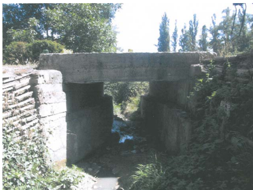
001-CAVAAG009 – Attraversamento Rio Usignolo
