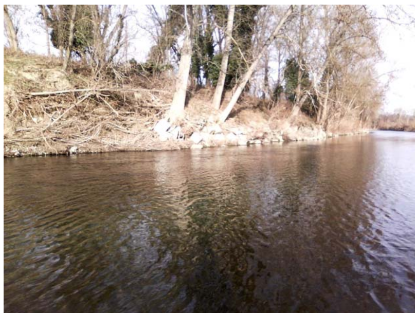
001-CAVADS004 – Difesa in prismi in cls sponda sinistra Fiume Bormida Loc. Boassone
