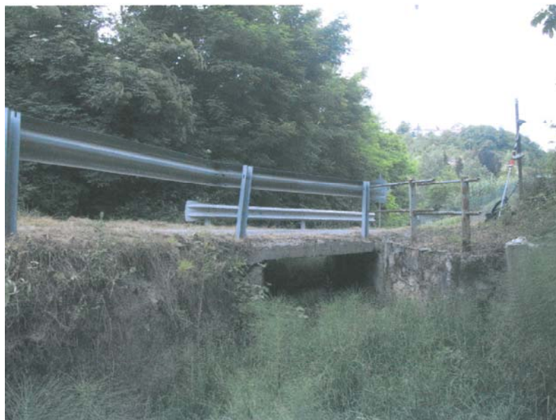
001-CAVAAG021 – Attraversamento Rio della Faetta
