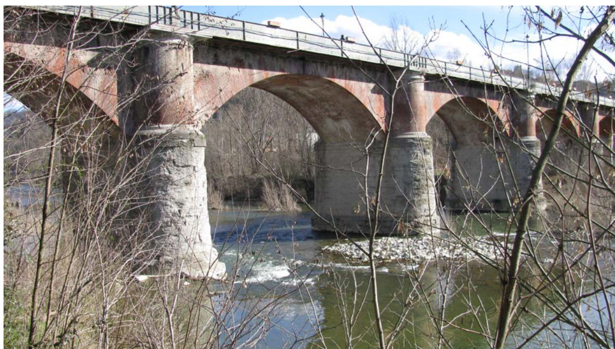
001-CAVAPO014 – Ponte Via Carlo Alberto vista da valle
