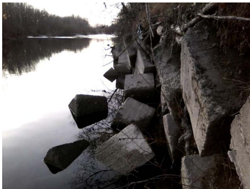
002-CAVADS004 – Difesa in prismi in cls sponda sinistra Fiume Bormida Loc. Boassone
