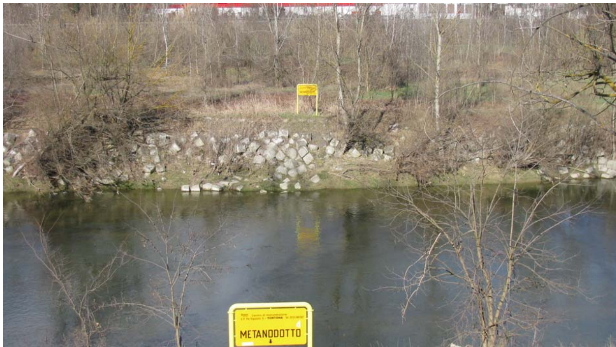
001-CAVADS001 – particolare prismata
