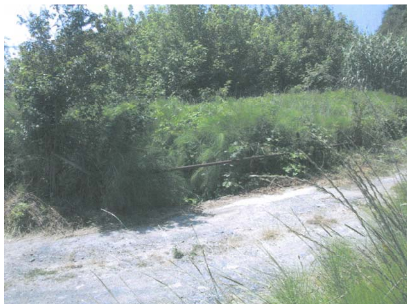
001-CAVAAG007 – Attraversamento diametro 1,2 m Rio Usignolo
