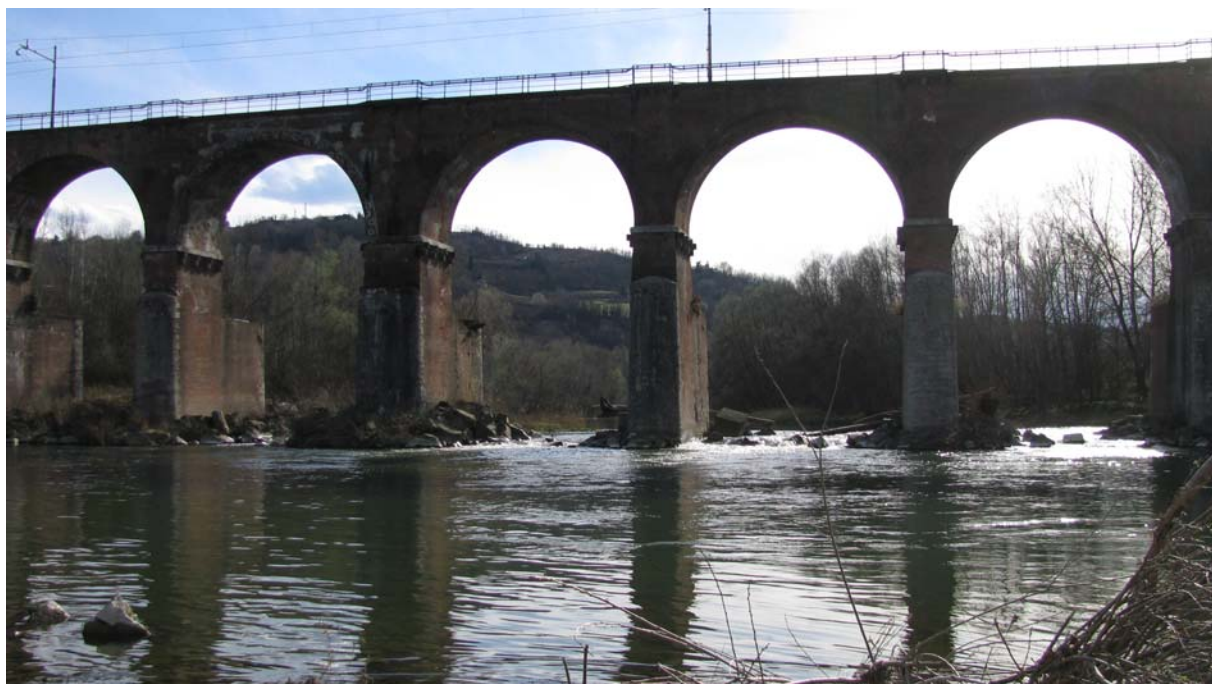
001-CAVAPO015 – Ponte ferroviario in località Lavandaro (Bormida)
