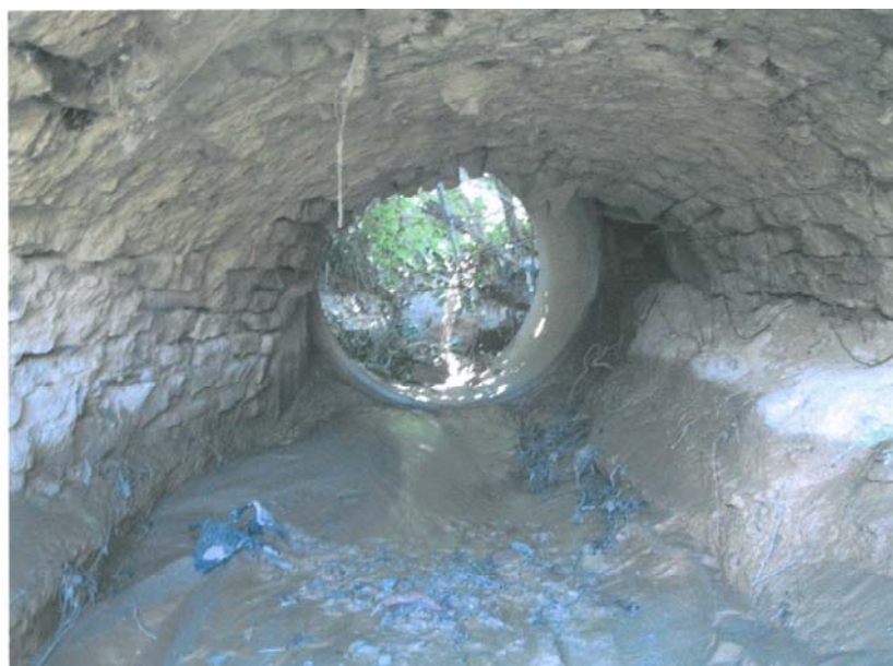
001-CAVAAG012 – Attraversamento Rio Usignolo
