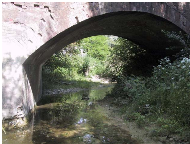
001-CAVAPO011 – Ponte ferroviario in muratura vista da valle
