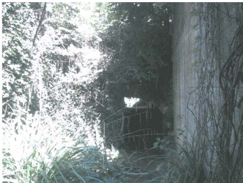
001-CAVAAG033 – Attraversamento Rio dell'Avlana Strada Melazzo
