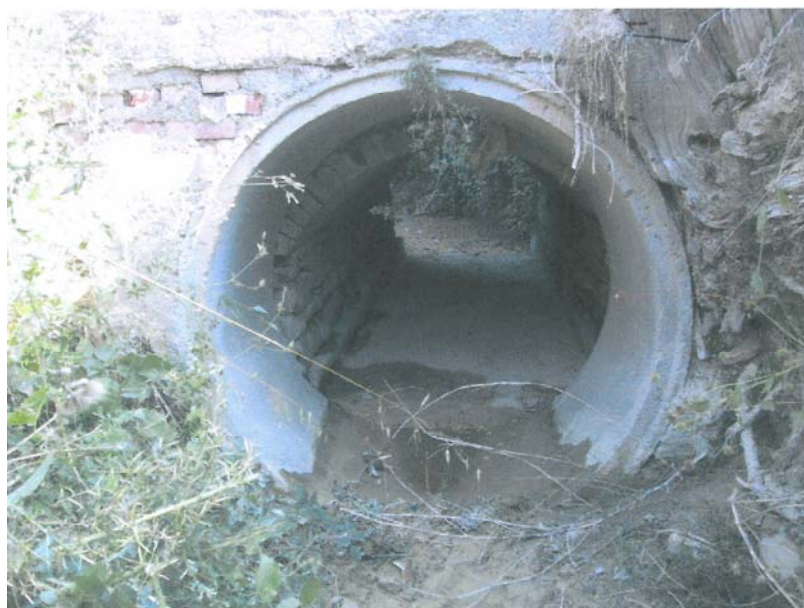
001-CAVAAG028 – Attraversamento Rio della Valle Str della Valle
