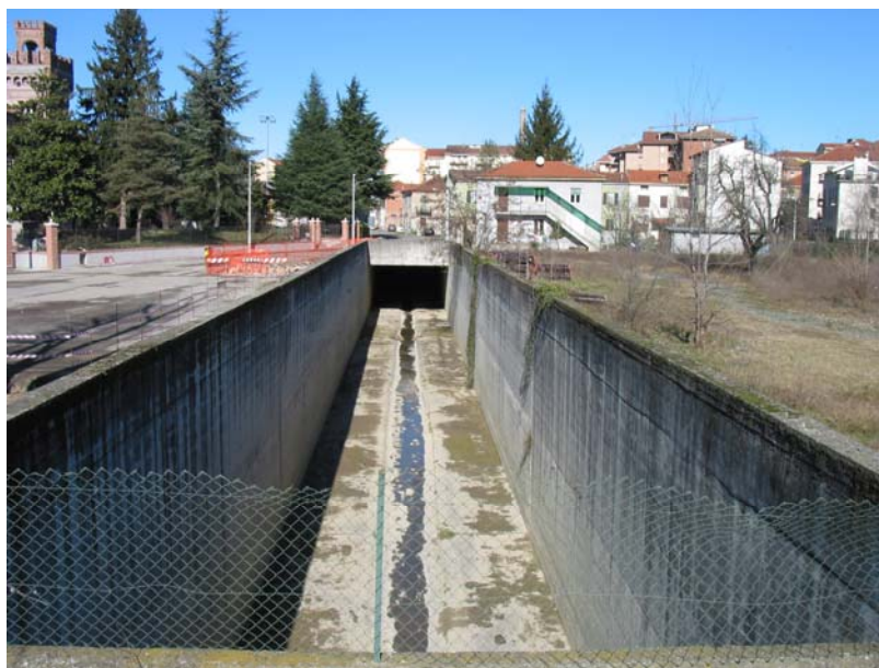
001-CAVACA004 – Canalizzazione Rio Medrio - vista da valle
