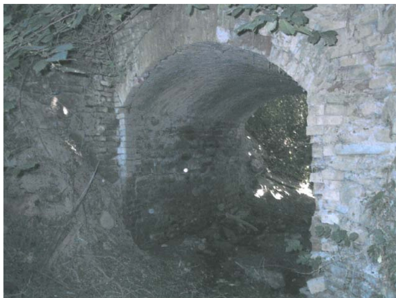
001-CAVAAG010 – Attraversamento Rio Usignolo
