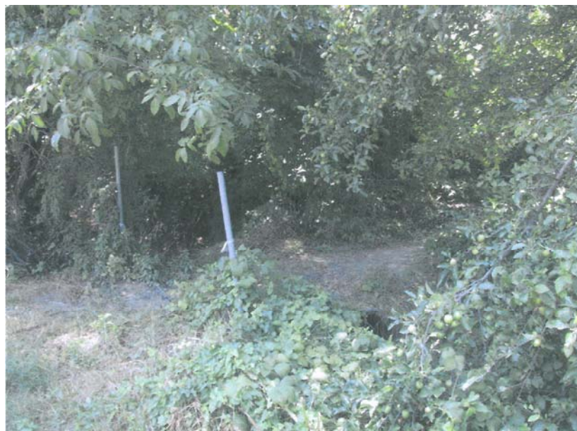
001-CAVAAG006 – Attraversamento diametro 1 m Rio Usignolo
