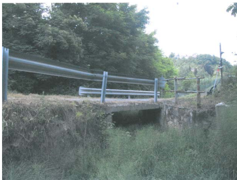
001-CAVAAG021 – Attraversamento Rio della Faetta
