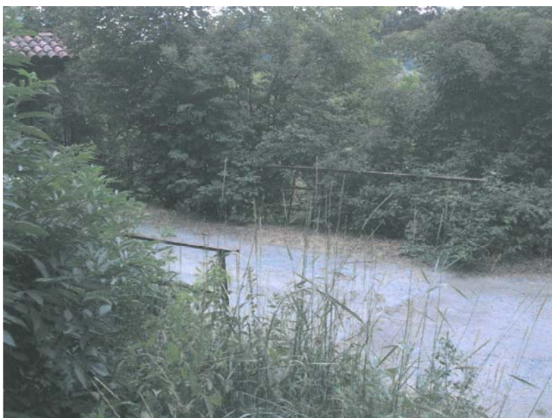
001-CAVAAG015 – Attraversamento Rio Casale Regione Bossalesio
