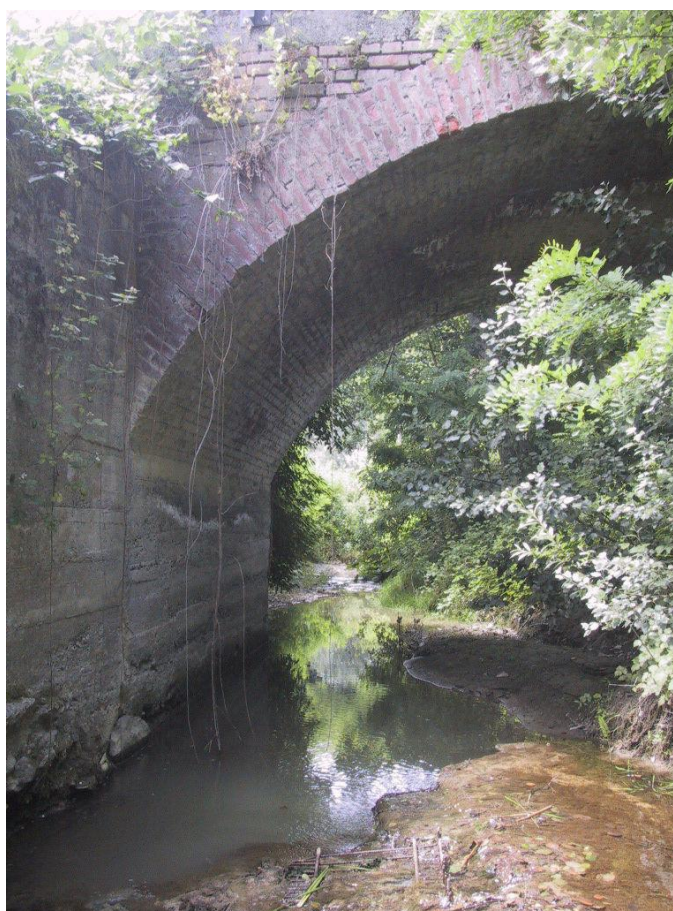
001-CAVAPO012 – Ponte stradale in muratura su strada campestre
