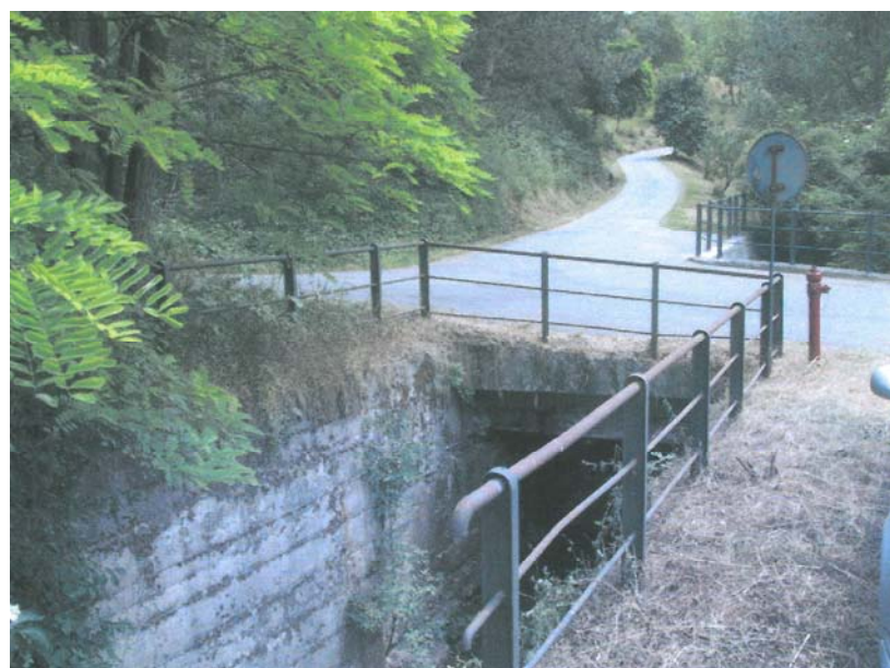
001-CAVAAG020 – Attraversamento Rio della Faetta
