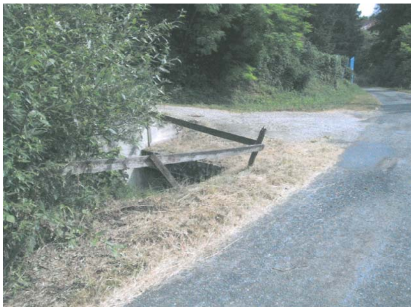
001-CAVAAG022 – Attraversamento Rio della Faetta
