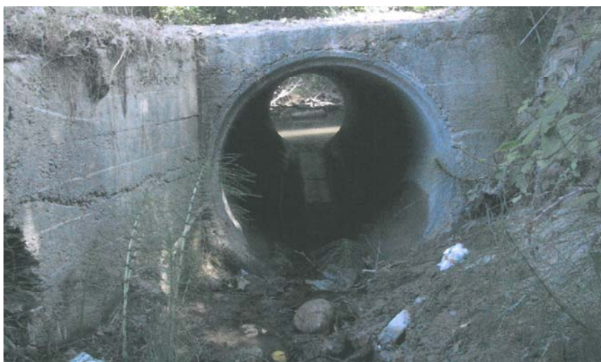
001-CAVAAG013 – Attraversamento Rio Casale Regione Bossalesio
