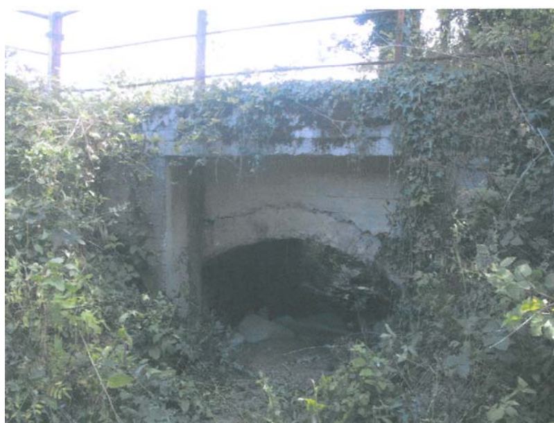
001-CAVAAG032 – Attraversamento Rio della Valle Loc. Uberti
