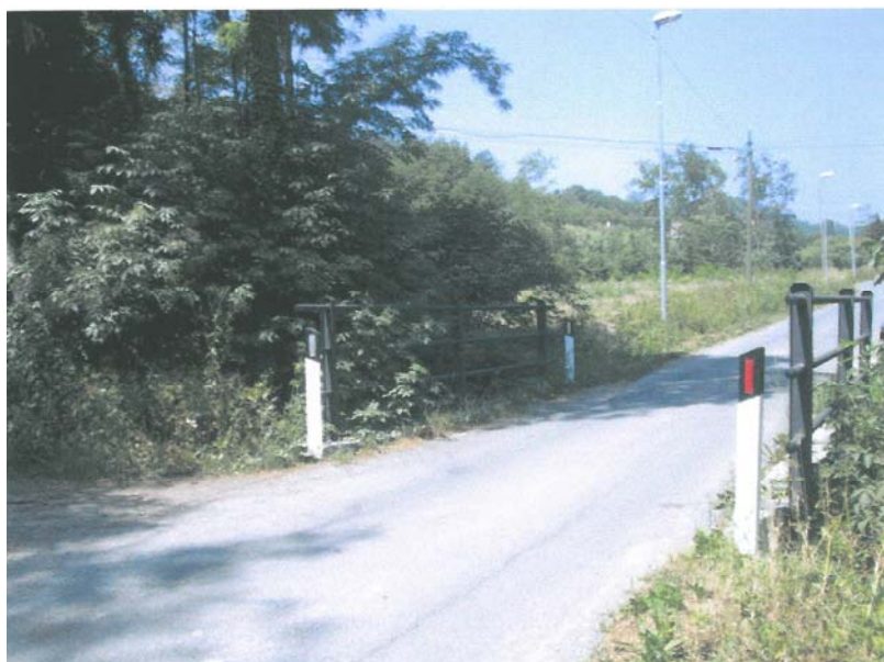
001-CAVAAG016 – Attraversamento Rio Casale Regione Bossalesio
