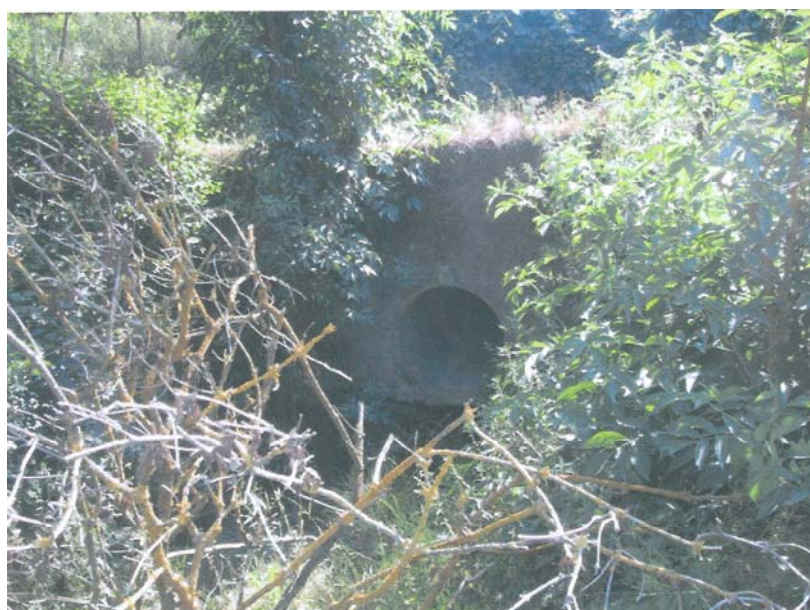
001-CAVAAG011 – Attraversamento Rio Usignolo
