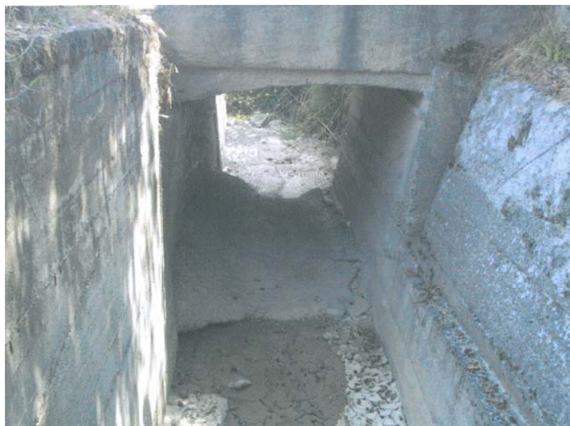
001-CAVAAG029 – Attraversamento Rio della Valle Loc. Ciravegna
