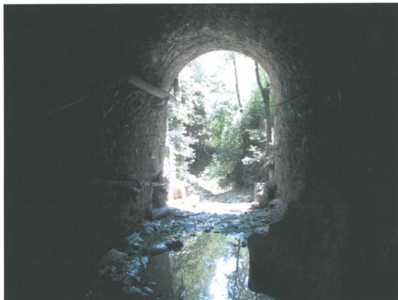
001-CAVAAG027 – Attraversamento Rio della Valle ex s.s.30
