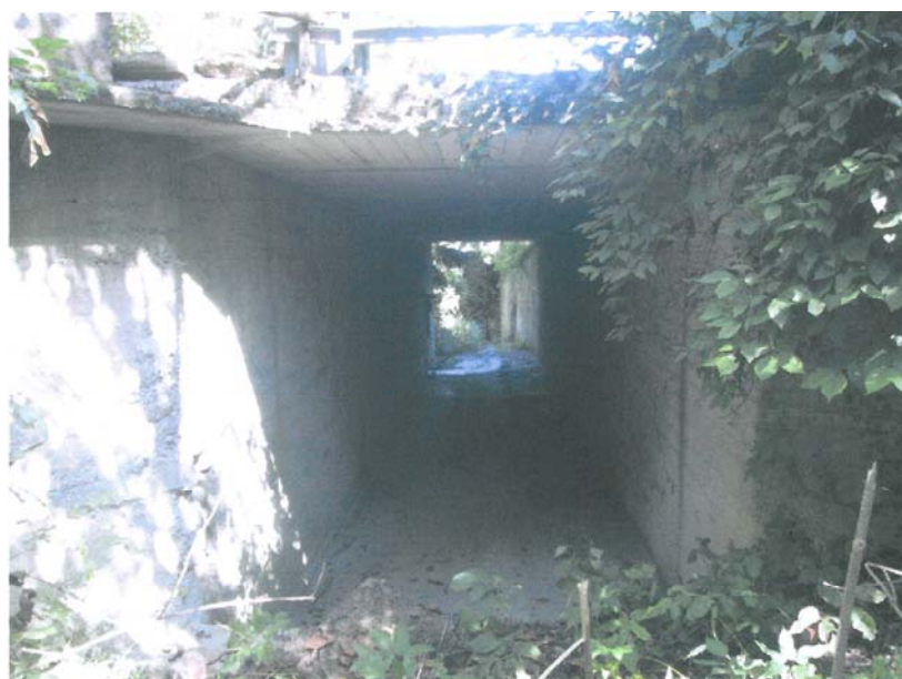
001-CAVAAG034 – Attraversamento Rio dell'Avlana Strada Melazzo
