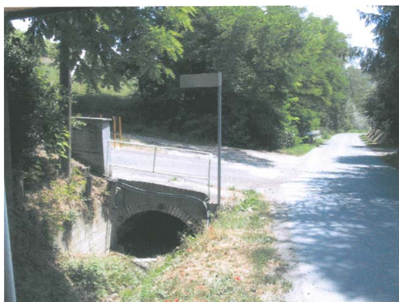
001-CAVAAG018 – Attraversamento Rio Casale Regione Bossalesio
