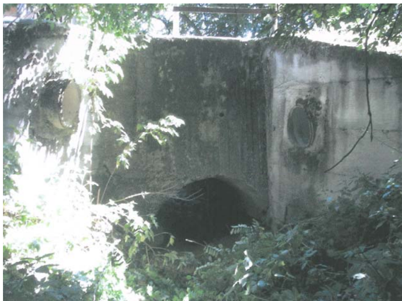
001-CAVAAG008 – Attraversamento Rio Usignolo
