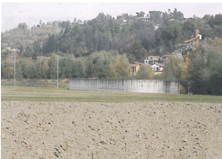
001-CAVABR008 - Briglia di trattenuta Rio Medrio- vista laterale
