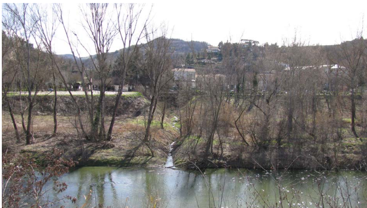
001-CAVAAR001/001-CAVAAR002 – Argine visto dalla sponda sinistra
