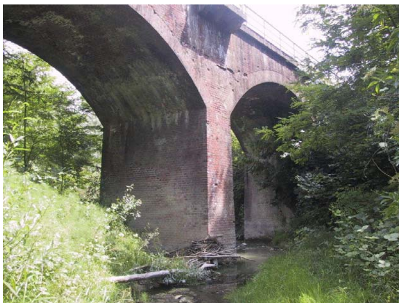
001-CAVAPO008 – Ponte ferroviario in muratura visto da valle
