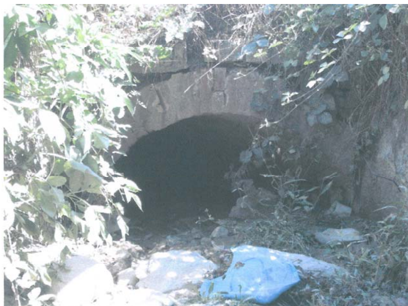
001-CAVAAG019 – Attraversamento Rio Casale Regione Bossalesio
