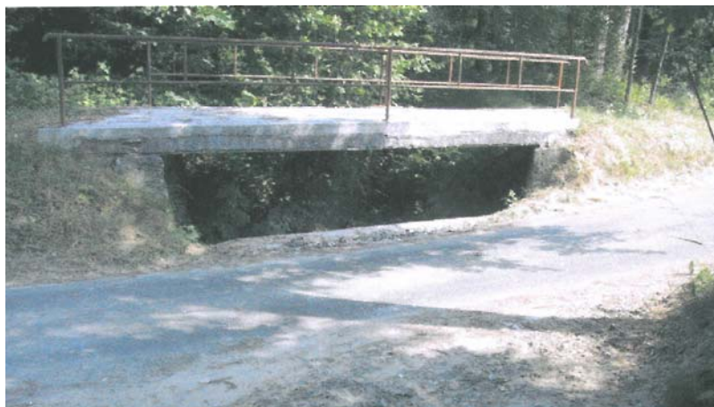
001-CAVAAG014 – Attraversamento Rio Casale Regione Bossalesio
