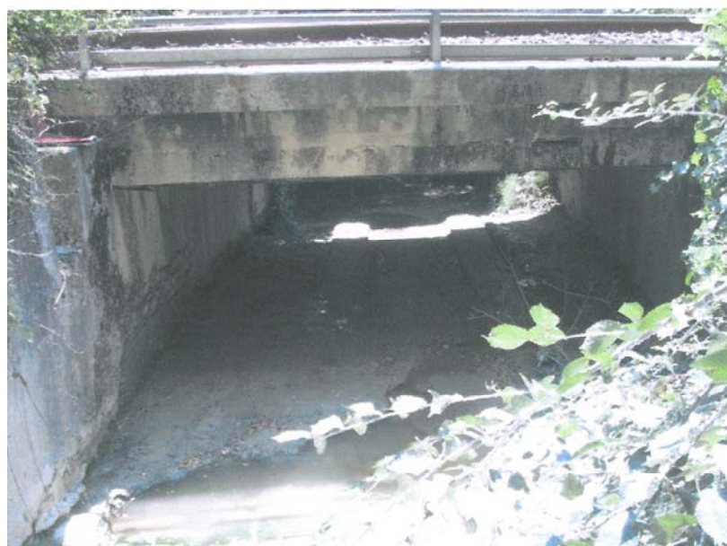
001-CAVAAG026 – Attraversamento Rio della Valle Loc. Barbato
