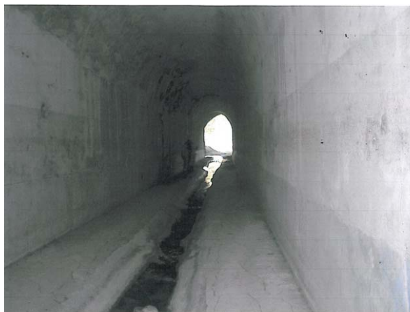
001-CAVACA002 – Canalizzazione destra Rio Ravanasco tratto terminale
