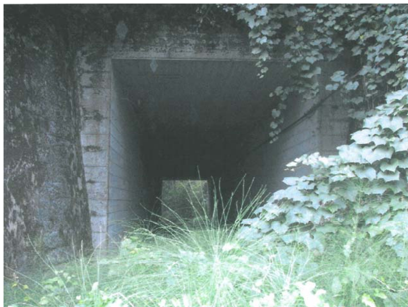
001-CAVAAG025 – Attraversamento Rio Gavanale ex S.S. 30
